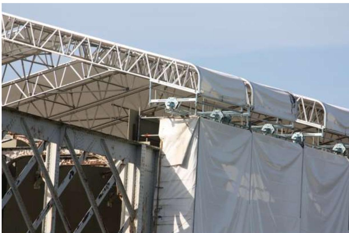
In questo modo si può attuare lo spostamento della copertura lungo tutta l'opera da servire, garantendo una notevole flessibilità nella pianificazione delle operazioni da eseguire
