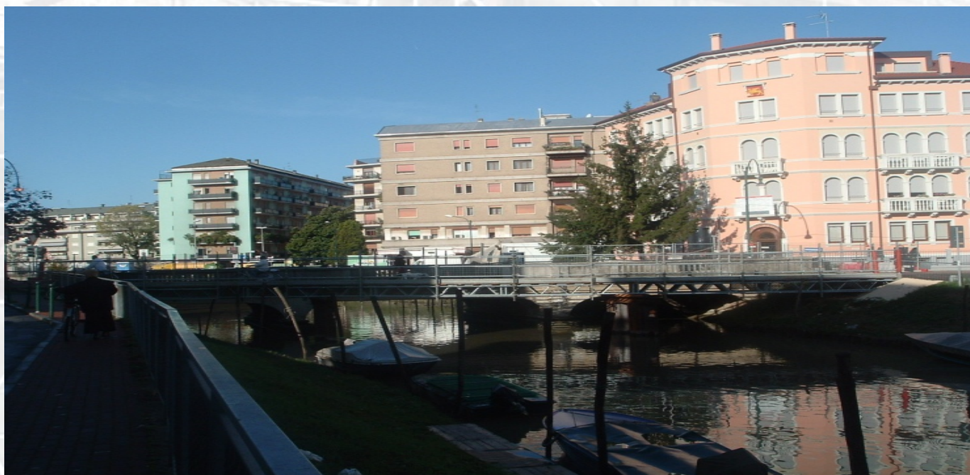
Figura 1 : Ponteggio corpo basso
