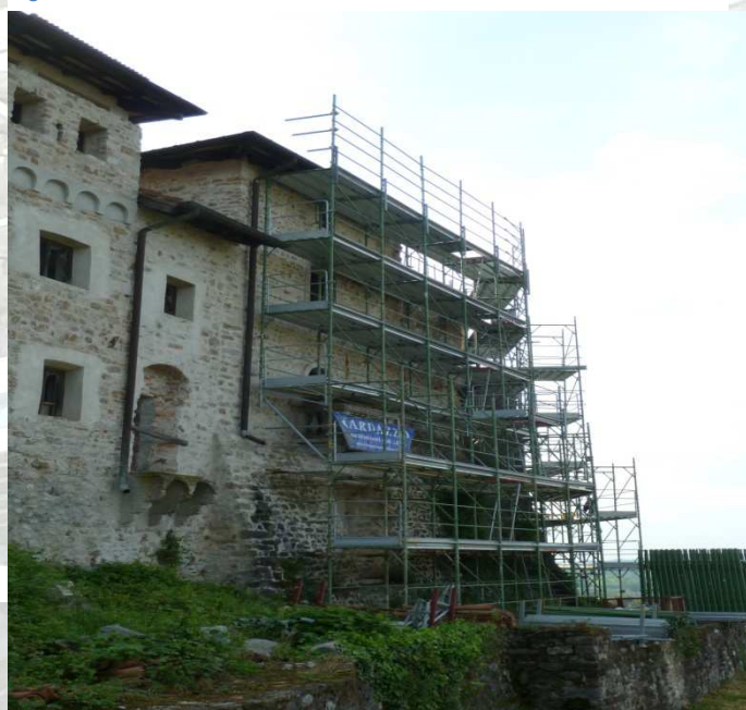
Figura 3 : Realizzazione di una porzione di ponteggio
