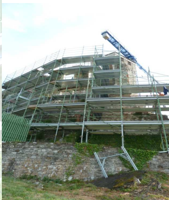
Figura 4 : ponteggio in elevazione
