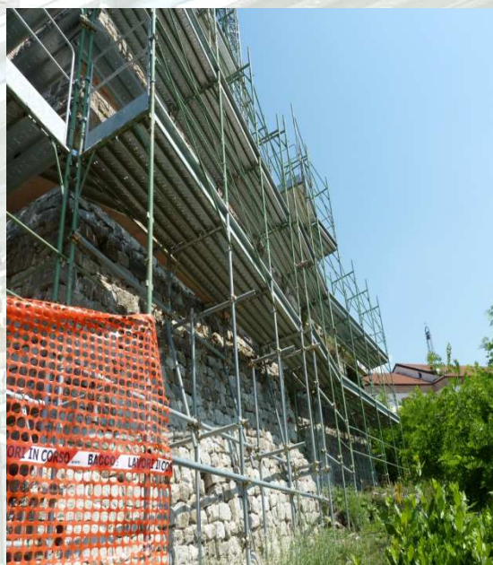
Figura 2 : Ponteggio in elevazione
