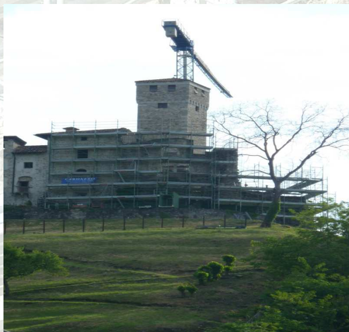
Figura 1 : Vista del cantiere
