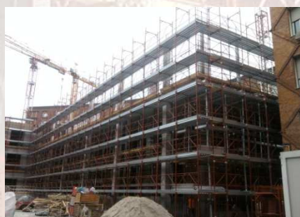
Figura 5 : Ponteggio in elevazione
