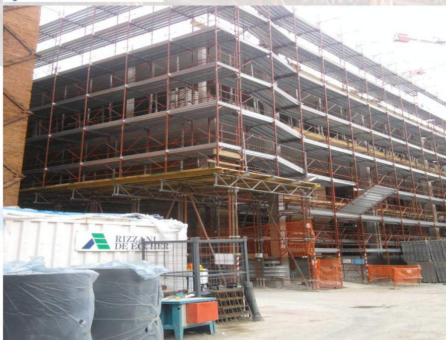
Figura 2 : Ponteggio in elevazione
