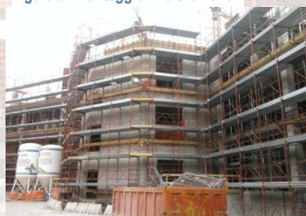
Figura 6 : Ponteggio in elevazione
