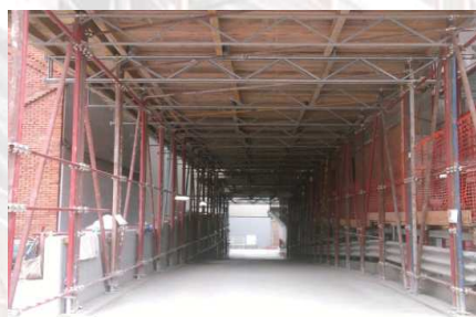
Figura 3 : Portale d'ingresso al cantiere
