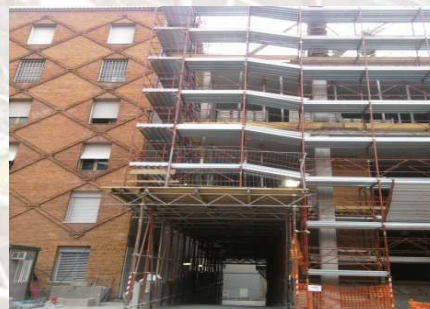
Figura 4 : Ponteggio in elevazione
