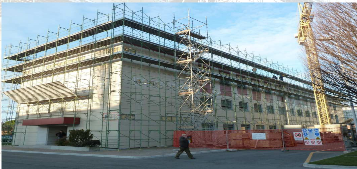
Figura 1 : Vista del ponteggio per la demolizione del cornicione di copertura
