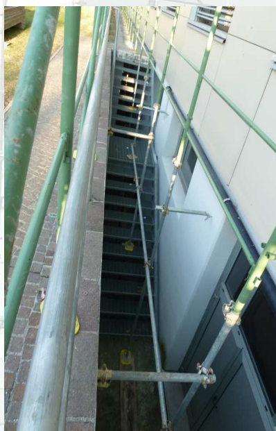
Figura 2 : Partenza in giunto-tubo
