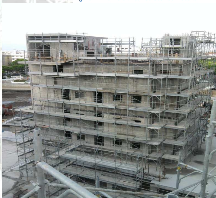
Figura 4 : ponteggio in elevazione per le opere in c.a.
