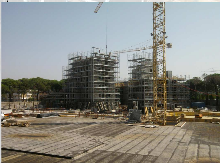
Figura 1 : Vista del cantiere primo blocco
