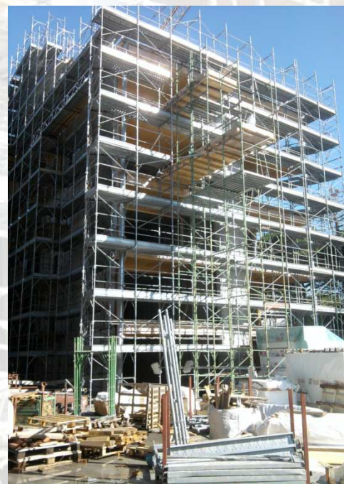
Figura 2 : Piazzole di carico-scarico materiali
