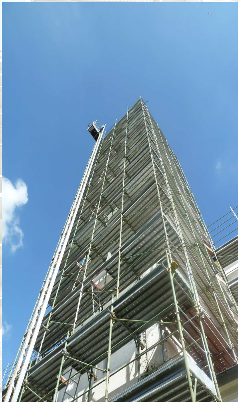
Figura 1 : Ponteggio sulla torre campanaria
