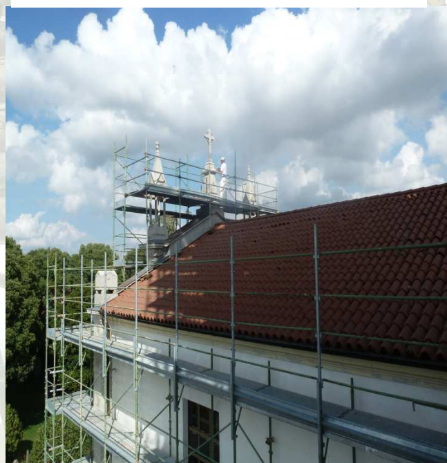
Figura 3 : protezione in copertura
