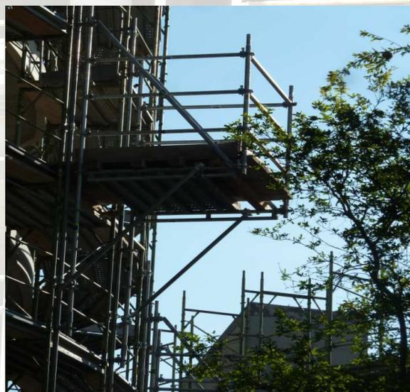
Figura 2 : Piazzola di carico MP Pilosio.
