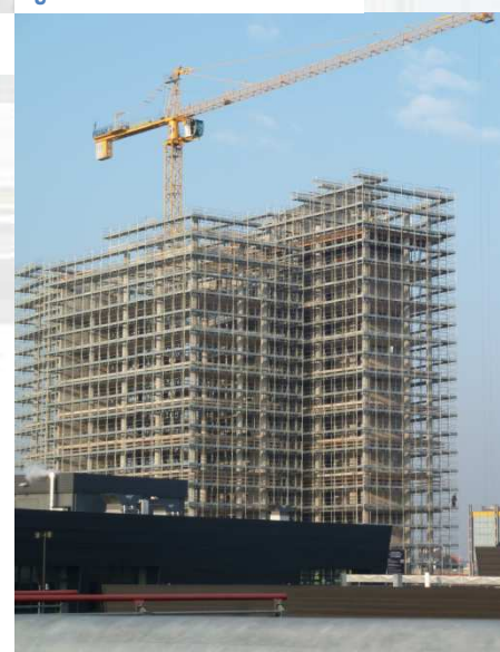
Figura 3 : Ponteggio in elevazione
