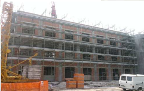
Figura 6 : Ponteggio in elevazione
