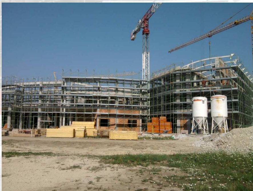
Figura 2: Ponteggio in elevazione
