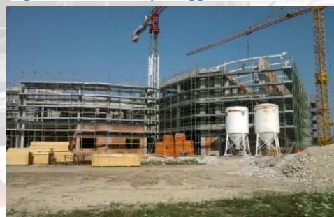
Figura 4 : Ponteggio in elevazione
