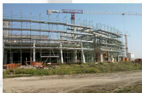
Figura 5 : Ponteggio in elevazione
