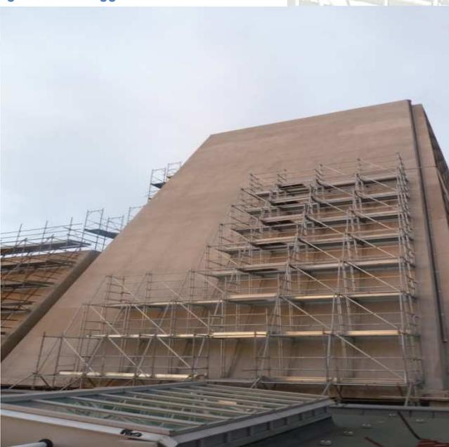
Figura 6 : Ponteggio in Mp Pilosio di somma urgenza
