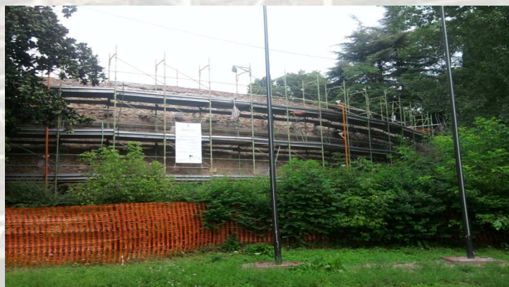
Figura 2 : Ponteggio di facciata
