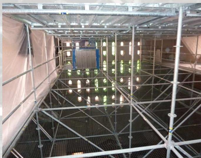
Figura 3 : Particolare del montacarichi Maber MB 800 in quota
