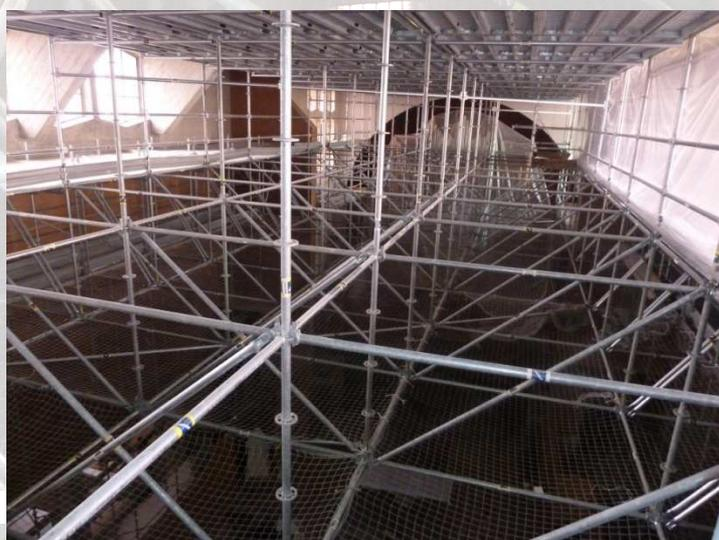
Figura 2 : Particolare della travatura MP Pilosio
