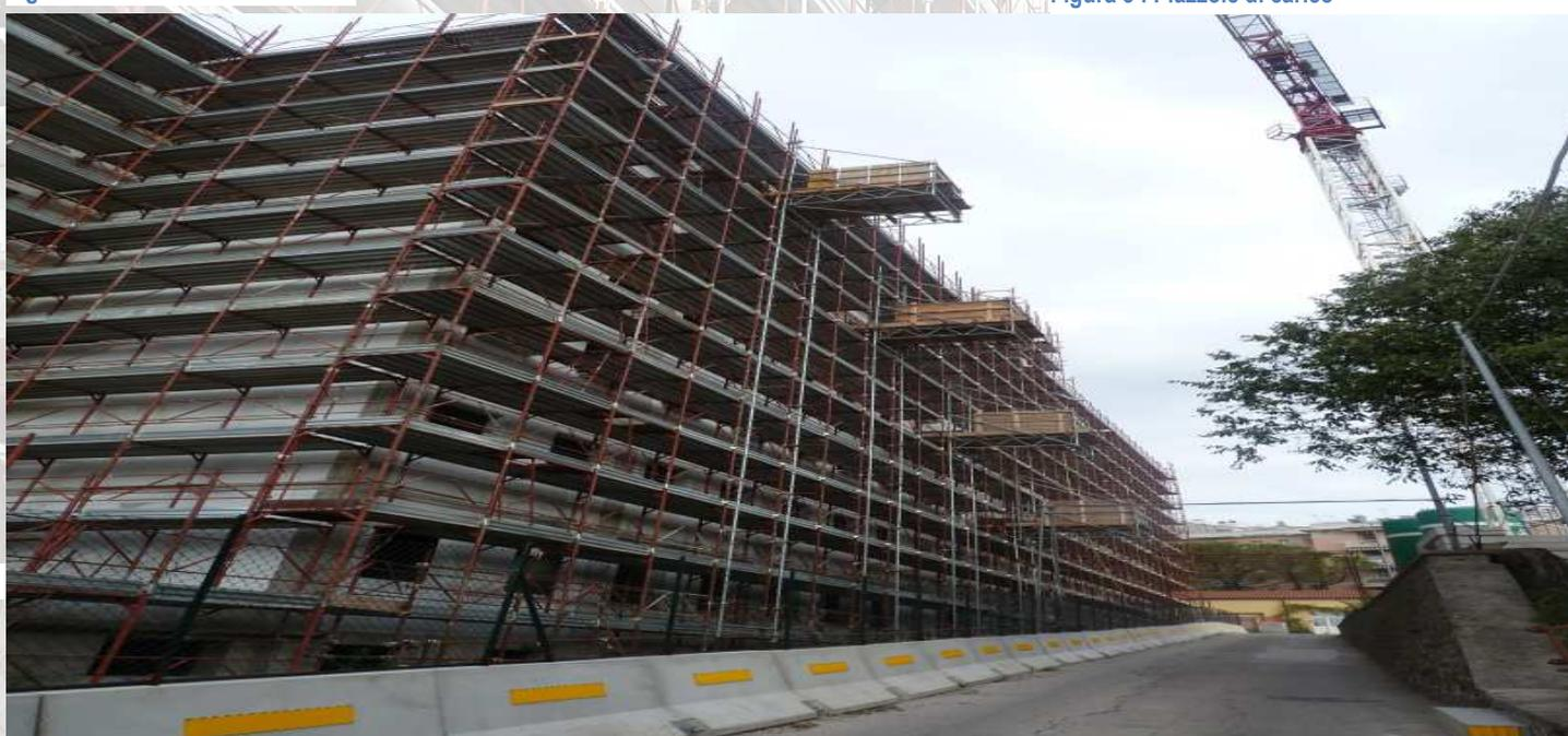
Figura 4: Ponteggio in elevazione
