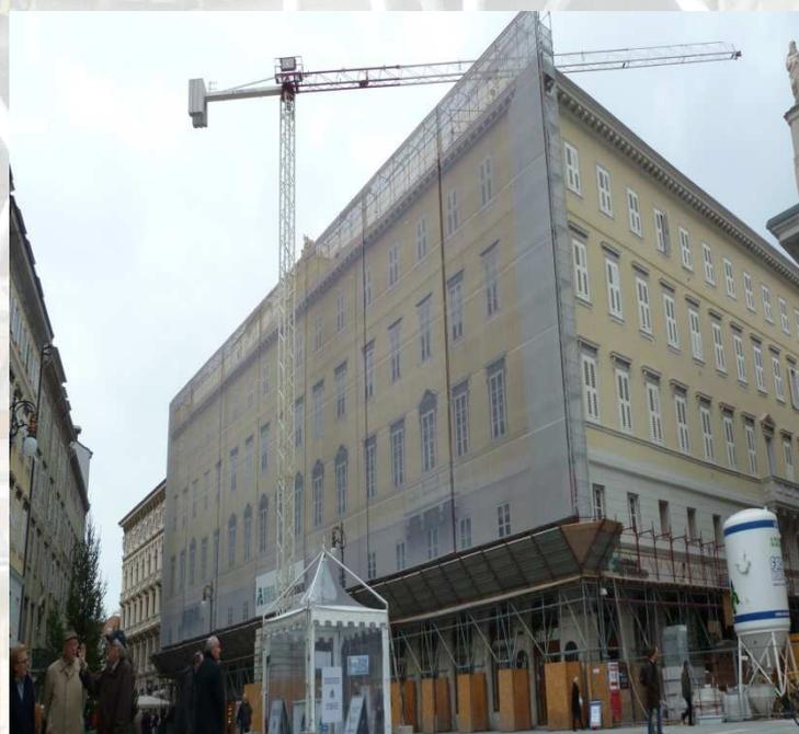
**Figura 1 : Ponteggio con telo microforato**
