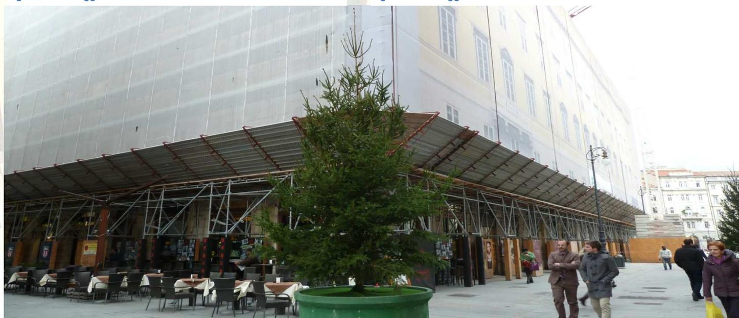
**Figura 3 : Sottopasso pedonale in MP Pilosio**
