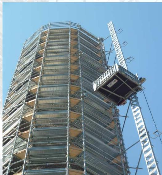
Figura 2 : Particolare del Montacarichi
