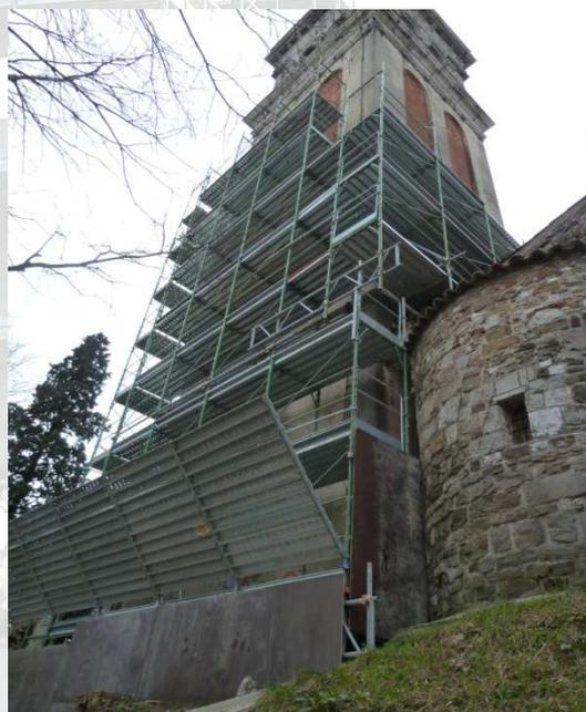
Figura 3 : Ponteggio in elevazione
