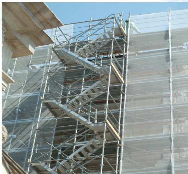
Figura 2 : Particolare della Scala MP Pilosio
