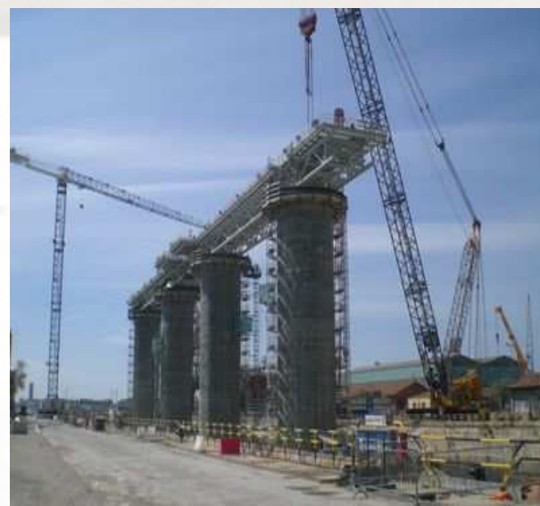
Figura 2 : Posizionamento della trave di collegamento
