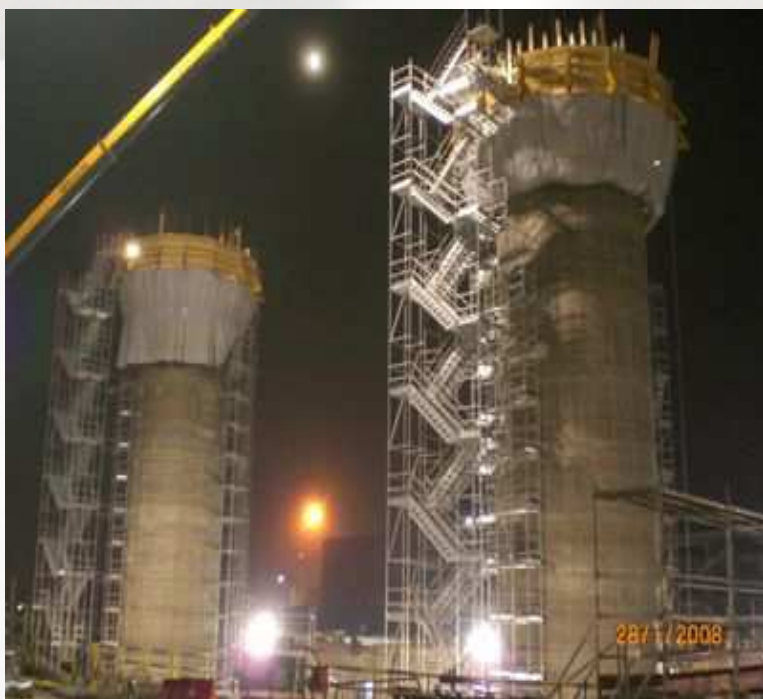
Figura 1 : Il cantiere di notte
