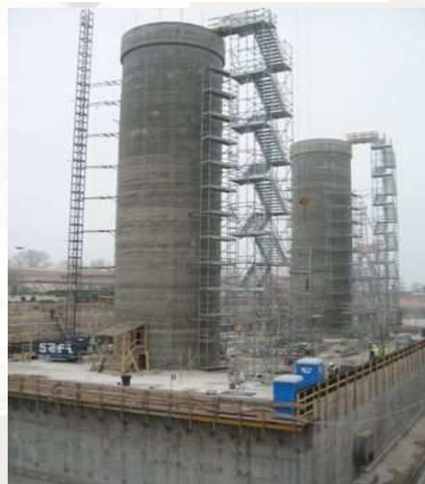
Figura 4 : Le strutture in elevazione
